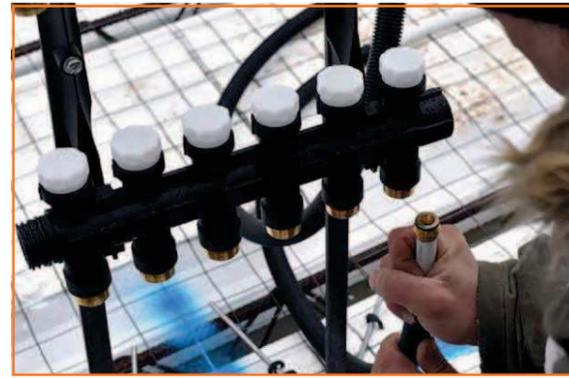
**4** Raccordement des tubes au collecteur.
