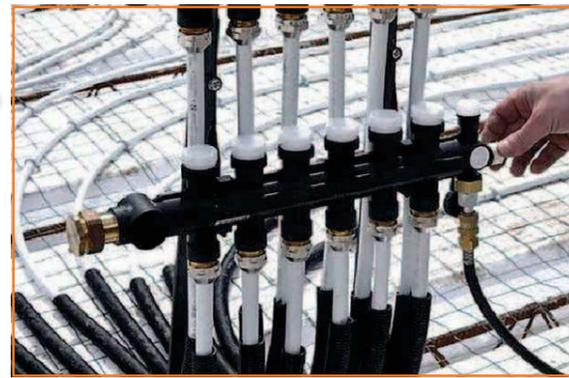
**5** Mise en pression de l'installation à plus de 3 bars. Pose du ferrailage complémentaire et coulage de la dalle de compression.
